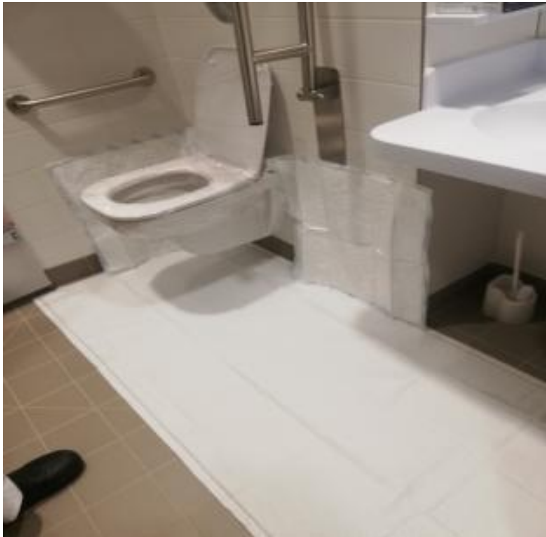
Wc chaud raccordé à une cuve
